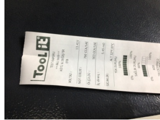
Elektrik donanımı/Pano, Akü > Test Sonucu
