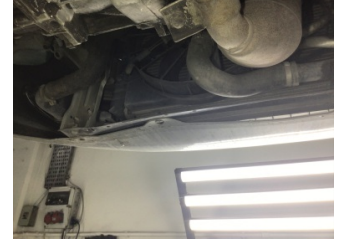
İlave parçalar, ön, Ön koruma demiri - bağlantı ayağı > Hasarlı
