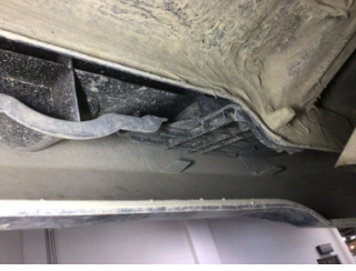
Tampon, arka, Bağlantı ayağı > Hasarlı
