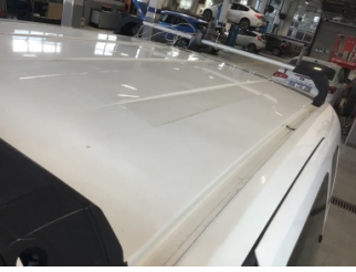
Tavan, Tavan > Hasarlı
