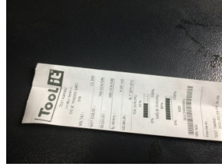
Elektrik donanımı/Pano, Akü > Test Sonucu
