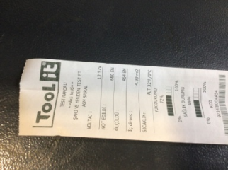
Elektrik donanımı/Pano, Akü > Test Sonucu
