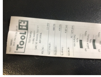
Elektrik donanımı/Pano, Akü > Test Sonucu
