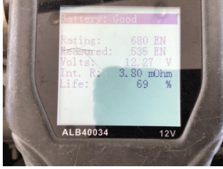
Elektrik donanımı/Pano, Akü > Test Sonucu
