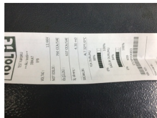
Elektrik donanımı/Pano, Akü > Test Sonucu
