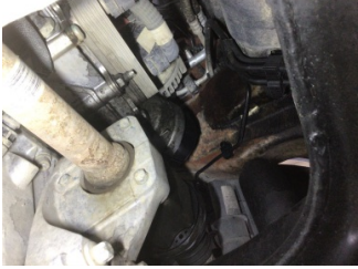
Motor, Yağ filtresi muhafazası > Yağ Kaçağı
