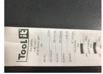
Elektrik donanımı/Pano, Akü > Test Sonucu
