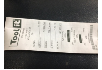
Elektrik donanımı/Pano, Akü > Test Sonucu
