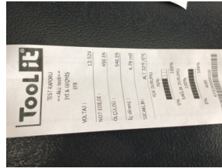
Elektrik donanımı/Pano, Akü > Test Sonucu
