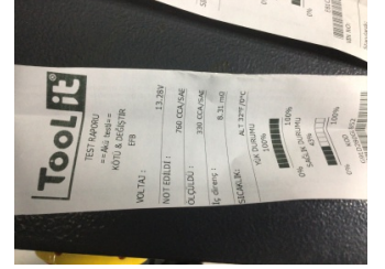
Elektrik donanımı/Pano, Akü > Test Sonucu
