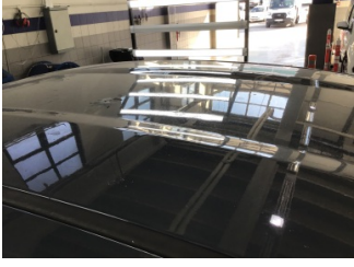
Tavan, Tavan > Dolu Hasarı
