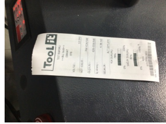
Elektrik donanımı/Pano, Akü > Test Sonucu
