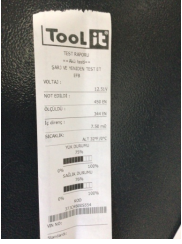
Elektrik donanımı/Pano, Akü > Test Sonucu
