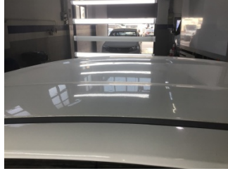
Tavan, Tavan > Dolu Hasarı
