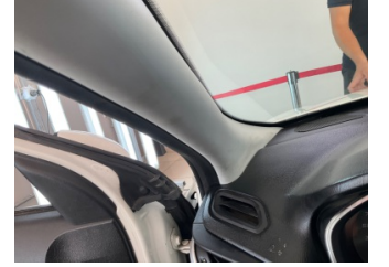
Döşemeler/Kapaklar, Döşemeler/Kapaklar > Kirlenmiş
