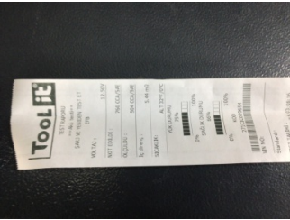
Elektrik donanımı/Pano, Akü > Test Sonucu
