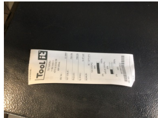
Elektrik donanımı/Pano, Akü > Test Sonucu
