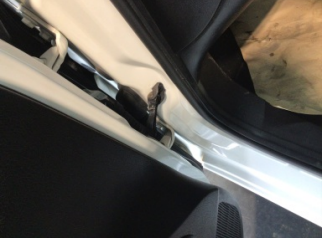
Kapı, sol ön, Kapı gergisi > Ses Yapıyor
