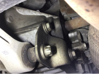
Ön aks, Aks mili, sağ > Yağ Kaçağı
