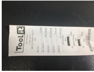
Elektrik donanımı/Pano, Akü > Test Sonucu
