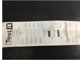
Elektrik donanımı/Pano, Akü > Test Sonucu
