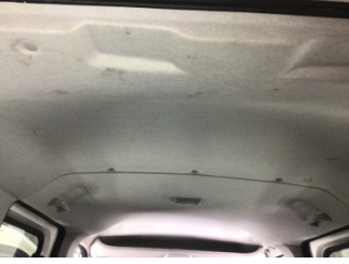
Döşemeler/Kapaklar, Tavan döşemesi > Kirlenmiş
