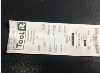
Elektrik donanımı/Pano, Akü > Test Sonucu
