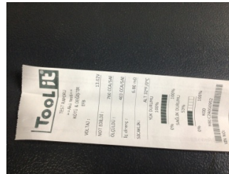
Elektrik donanımı/Pano, Akü > Test Sonucu
