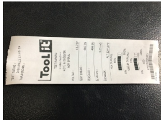
Elektrik donanımı/Pano, Akü > Test Sonucu
