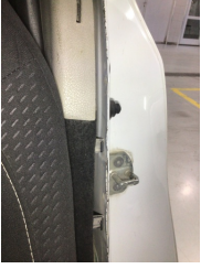
Kaporta, C-direk, sol > Standart Dışı Onarım
