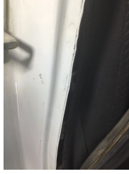
Kaporta, C-direk, sağ > Standart Dışı Onarım
