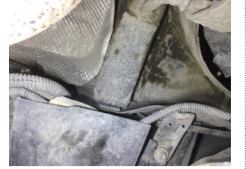
Kaporta, Sol Arka Şase > Standart Dışı Onarım
