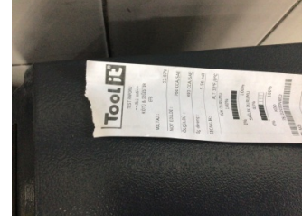
Elektrik donanımı/Pano, Akü > Test Sonucu
