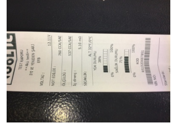
Elektrik donanımı/Pano, Akü > Test Sonucu
