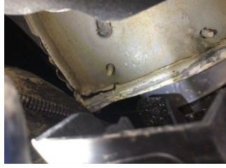
Arka bölüm, Bagaj havuzu > Hasarlı
