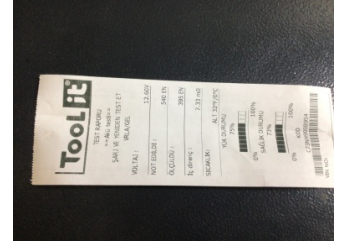
Elektrik donanımı/Pano, Akü > Test Sonucu
