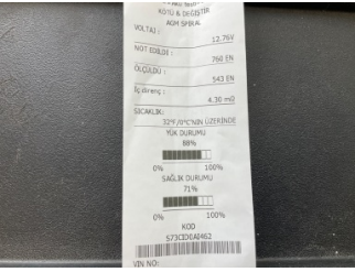
Elektrik donanımı/Pano, Akü > Test Sonucu
