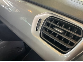
Kalorifer/Klima, Havalandırma ızgarası > Sabitlemesi Hatalı
