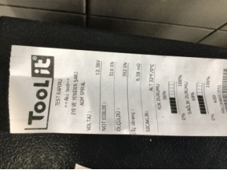
Elektrik donanımı/Pano, Akü > Test Sonucu
