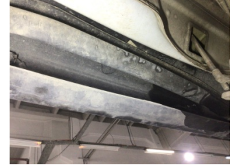
Arka bölüm, Römork çeki demiri > Hasarlı
