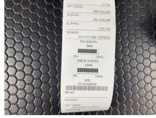
Elektrik donanımı/Pano, Akü > Test Sonucu
