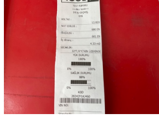
Elektrik donanımı/Pano, Akü > Test Sonucu
