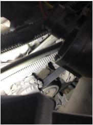
Motor, Motor bloğu > Yağ Kaçağı
